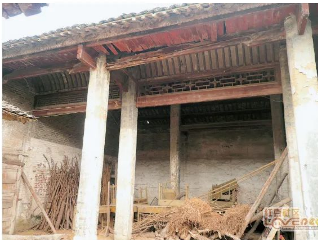
原来宾县县城——城厢老街一处旧建筑
